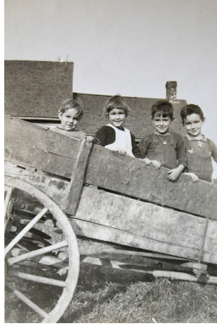
Réjean, Yvette, Robert et Réal, face à la maison à St-Hugues, avant sa démolition
