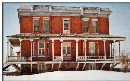
Presbytère avant la rénovation
