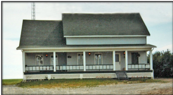
Maison à Bromptonville
